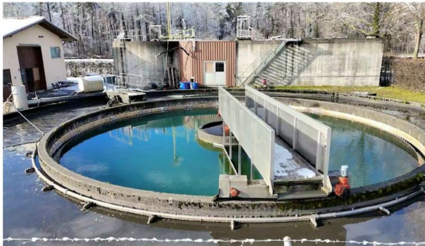
La STEP d'Henniez, en bonne santé, permettra de récupérer la chaleur des eaux pour le futur chauffage à distance. Une des étapes clés du projet communal. PHOTO SIH
